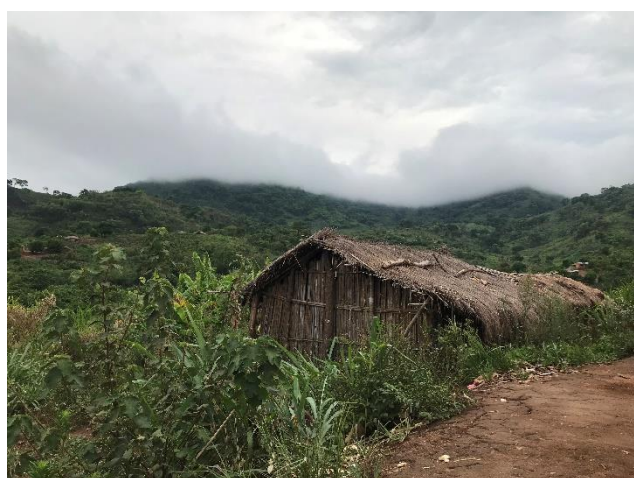
Figura 17 – Habitação com paredes de bambu e cobertura de palha (muito vulnerável) – Mucuera, 2021
