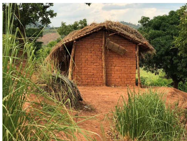
Figura 15 – Habitação com paredes blocos de barro e cobertura de palha (médio) – Mpemula-sede, 2021
