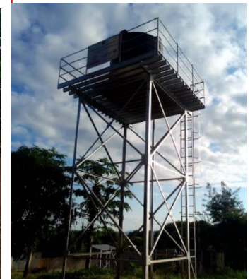
Figura.12.6. Fonte de Água operacional com tanque e painéis solares (Limbué)
