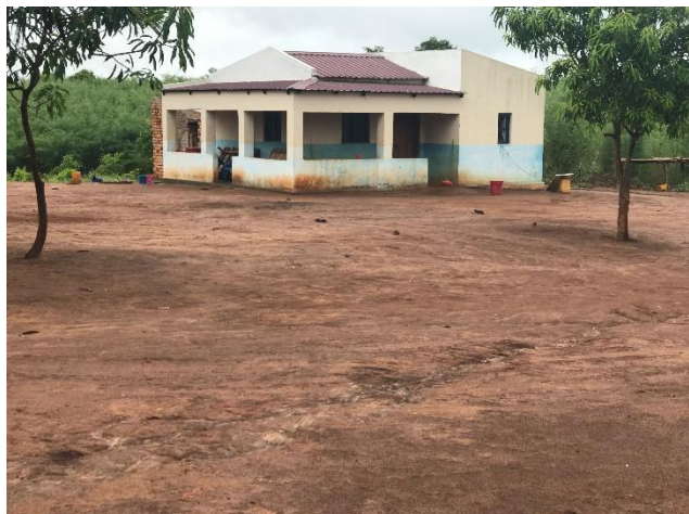
Figura 14 – Habitação com paredes de cimento e cobertura de chapa (muito resiliente) – Limbue, 2021
