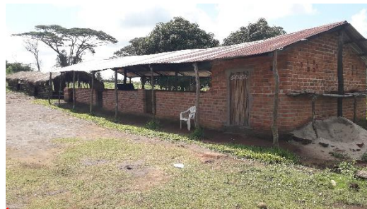
Fig. 10.3. Escola Primária de Completa de Dabuada
